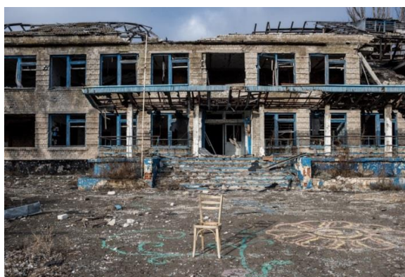
Школа в Широкино, поврежденная в результате обстрела в 2015 году
