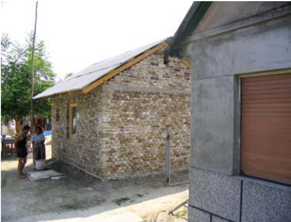
Слика 2: Нова кућа је изграђена од рециклиране опеке у Апатину
