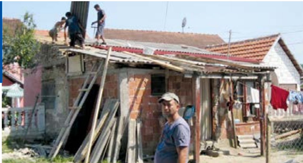
Слика 13: Замена неуловног кровног покривача у Грдичној носи 2 у Краљеву
