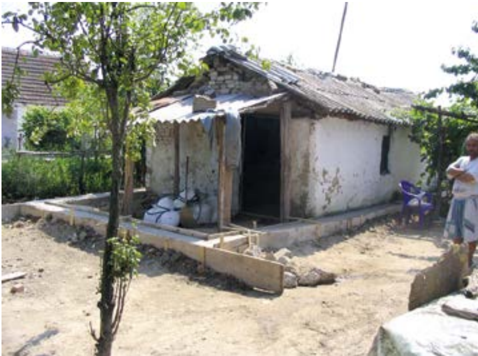
Слика 33: Око пропале куће у Апатину подигнут је темељ за нову кућу
