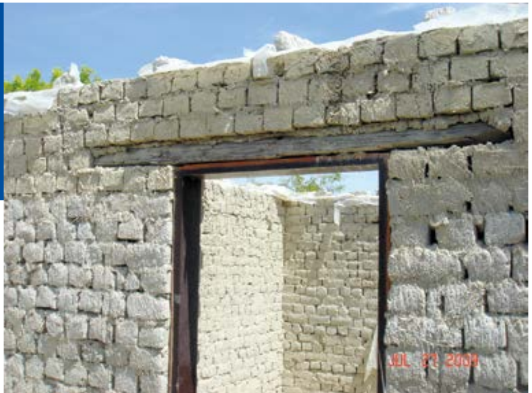
Слика 38: Деталј надвратника на започетој кући од ћерпича
