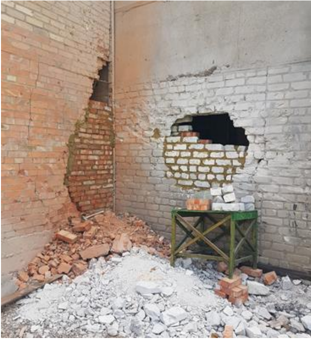
Ремонт пошкодженої стіни основного корпусу насосної станції в Київському районі Донецька, травень 2021 р.
