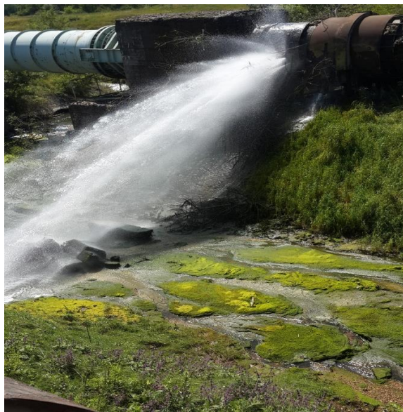
Рис. 2: Поврежденный водопровод у Горловки, 2015г.
