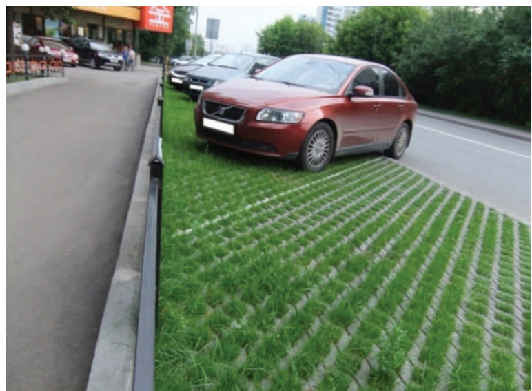
Рисунок 7. Использование водопроницаемых стоков вдоль дорог
