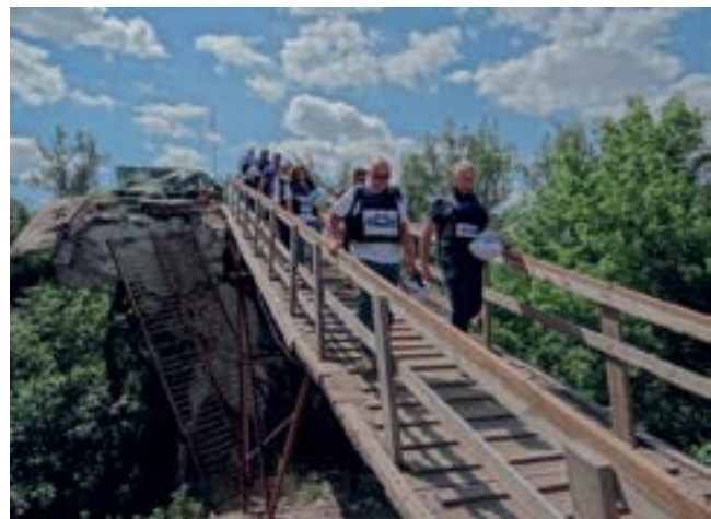
Заместитель Главного наблюдателя Марк Этерингтон и другие сотрудники СММ ОБСЕ осматривают обрушившийся пролет моста в Станице Луганской перед началом работ по его восстановлению, Станица Луганская (Луганская область), июль 2019 года. (ОБСЕ/Оксана Добровольская)
